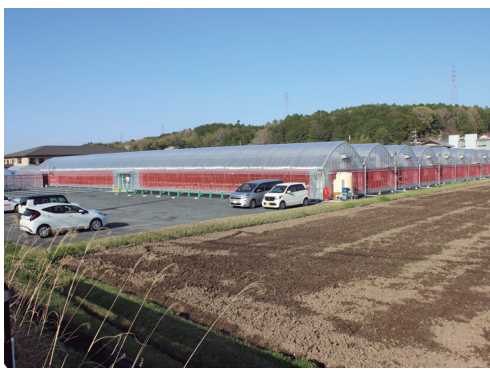
岐阜県可児市に設けられた「中電ウイングファーム」
