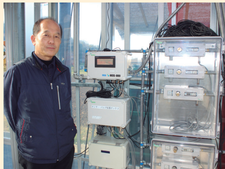
藤原社長と、『中電ウイングファーム』に設けたCO 2 局所施用システム
